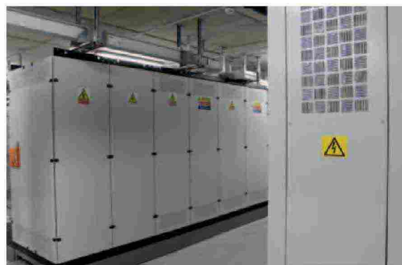
L'assenza di olio nei trasformatori isolati in resina Green T.HE (Green Trasformes High Efficiency) di BTicino, garantisce elevati valori di affidabilità e sicurezza
