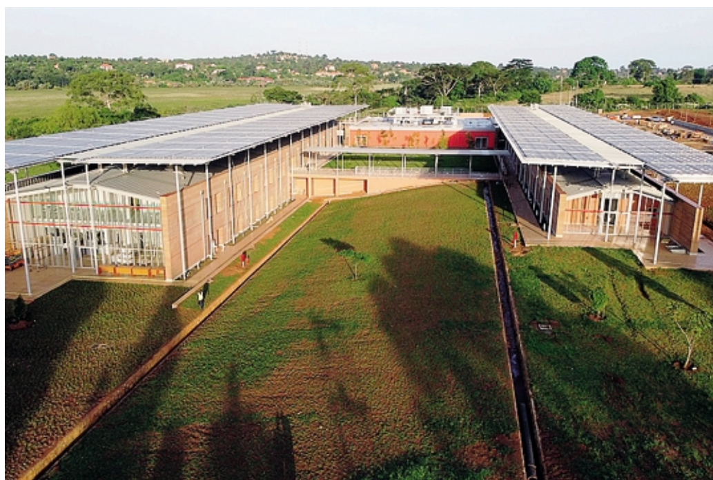
Il centro chirurgico pediatrico realizzato da Emergency in Uganda a cui ha collaborato l'azienda Milani
