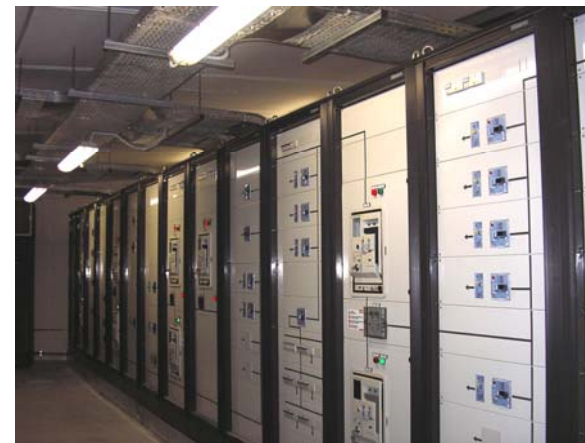
Armadio Power Center con Megatiker e Megabreak fino a 2000A
