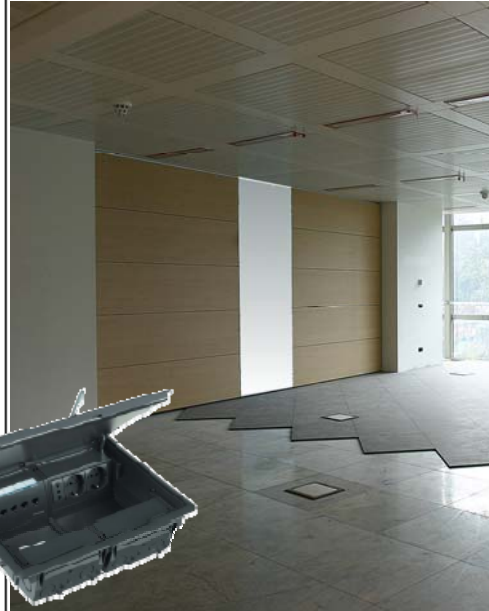
Esempio di ufficio cablato in categoria 5E BTNET con torrette a scomparsa della serie INTERLINK
