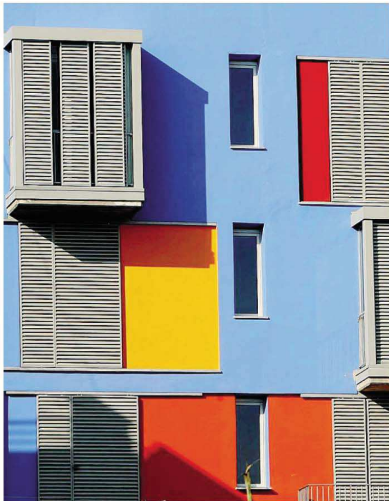
Un particolare del villaggio olimpico di Torino, l'ultimo realizzato in Italia nel 2006 ARCHIVIO
